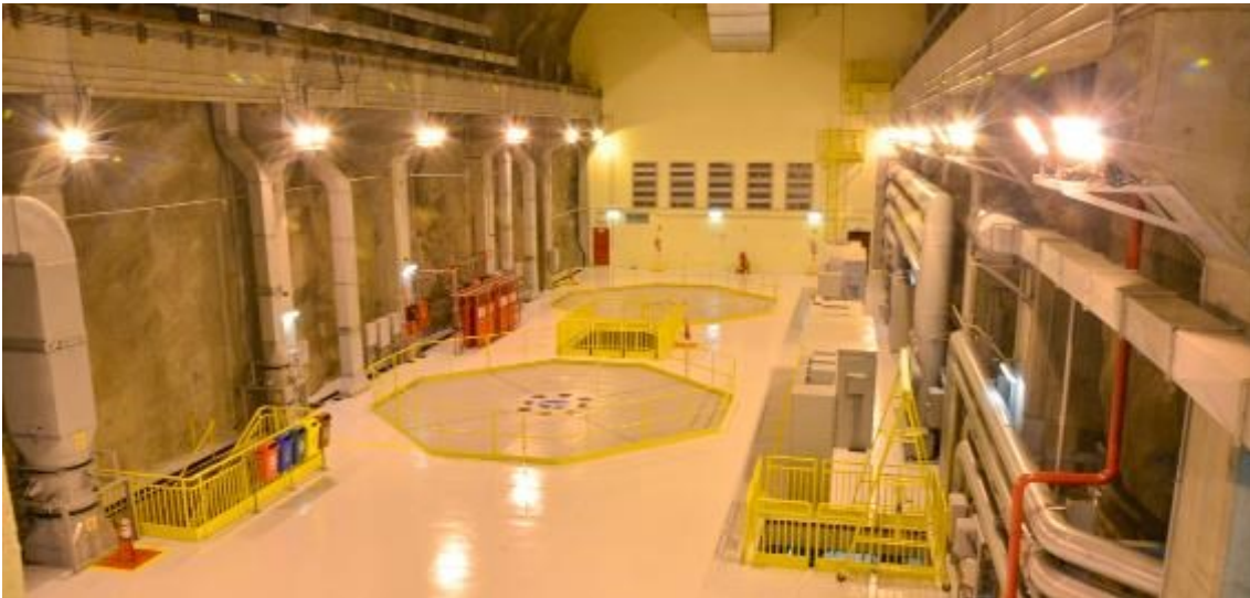
Foto 2 - Vista Interna da Casa de Força
